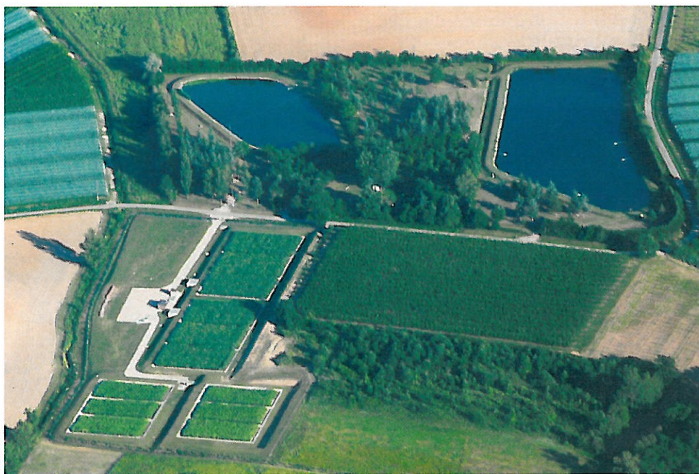
Vue aérienne de la station : en haut, les 2 lagunes, en bas, à gauche, les 2 étages de filtres
